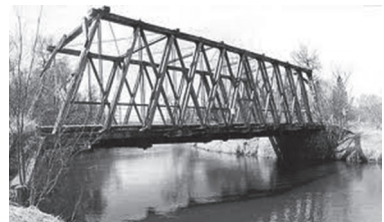
Gambar 9.27 Jembatan dengan tiang penyangga besi
